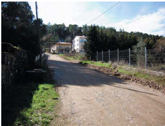
La pluja ha suposat un major deteriorament dels camins urbanitzats
