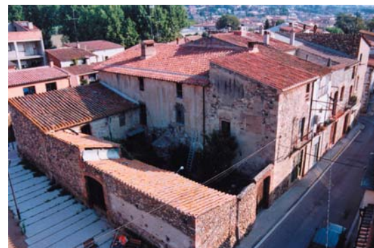
Vista del casal des del campanar
