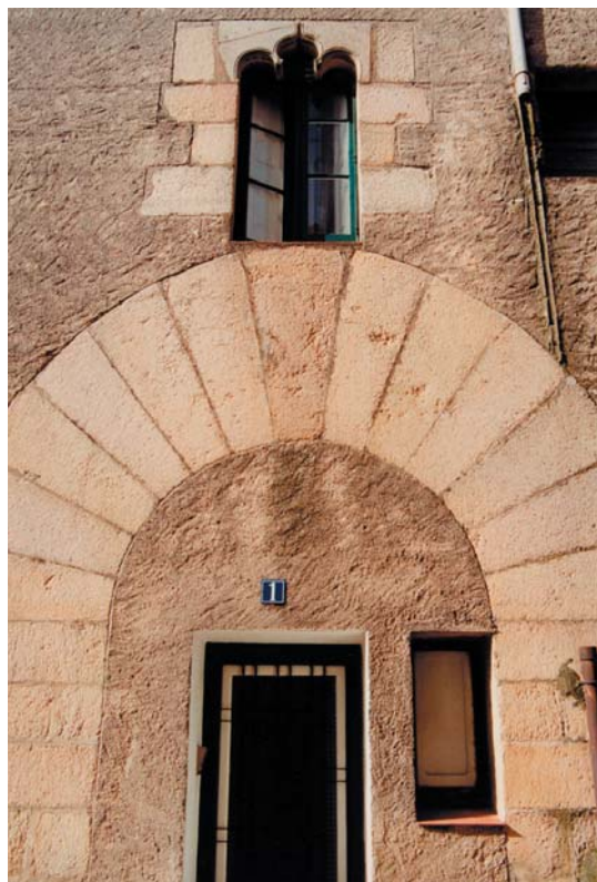
Antic portal principal de l'edifici
