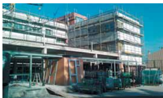
Obres d'ampliació al CEIP Montnegre de la Batllòria
