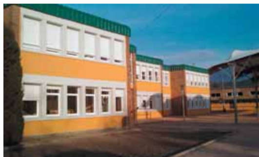
Millors al CEIP Pallerola, amb la instal·lació d'unes baranes de protecció
