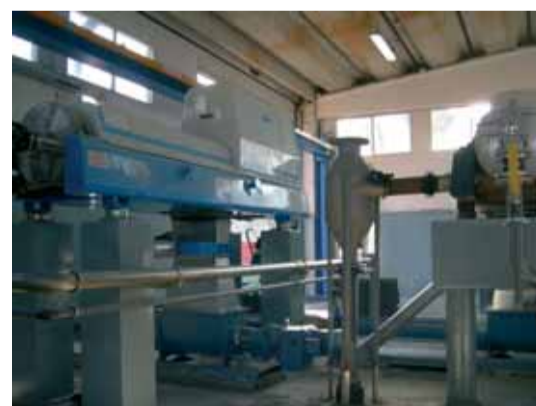
Milliores a la sala de deshidratació de la depuradora de Sant Celoni
