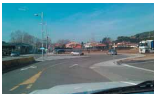
Urbanització del polígon 1 del sector Cementiri
