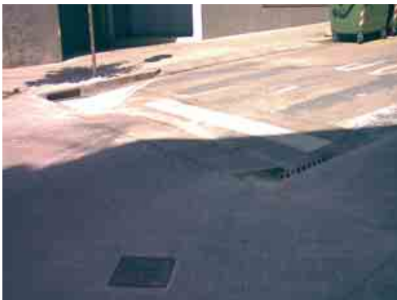
S'ha matisat el pas de ressalt del carrer de Germà Emilià amb Major amb un pendent més suau
