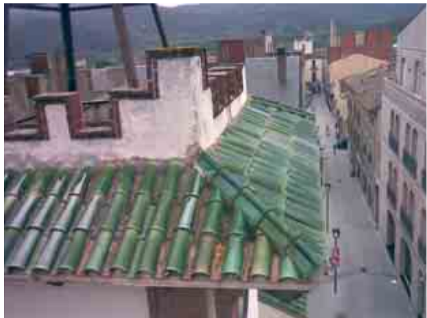
El teulat després de la intervenció
