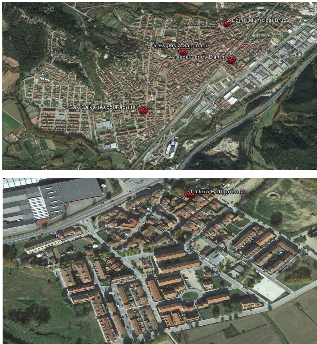
Figura 3: Ubicaciones candidatas a la instalación de los equipos Concentrador VHF
