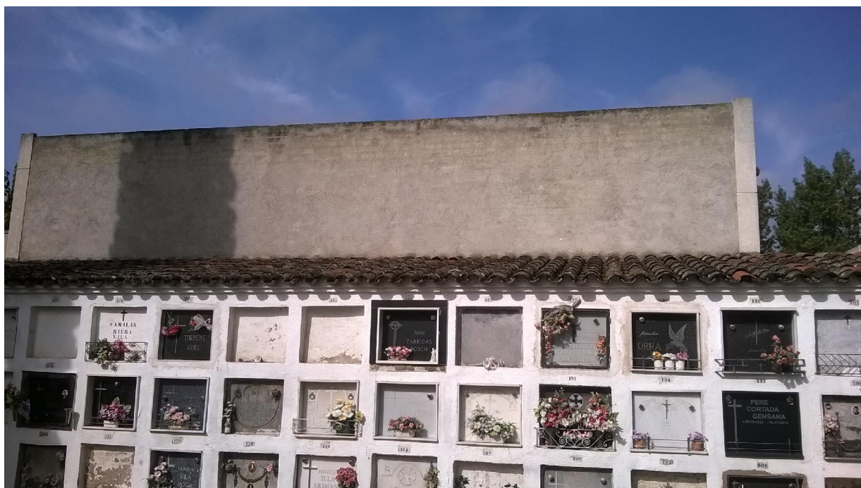
Foto 6. Vista posterior de l'edifici de ninxols existent.
