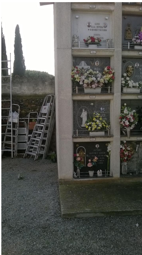
Foto 5. Vista frontal del inici de la prolongació de l'edifici.
