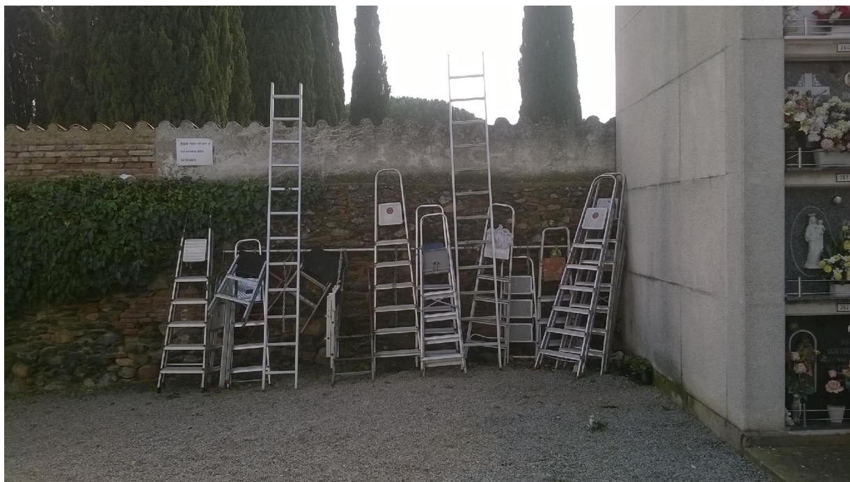
Foto 1. Inici de la prolongació del nou edifici de ninxols.
