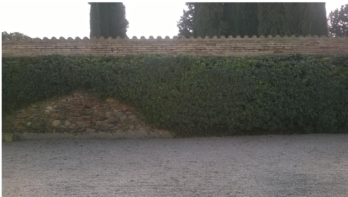
Foto 3. Vista frontal de la paret on s'ubicarà el nou edifici de ninxols.
