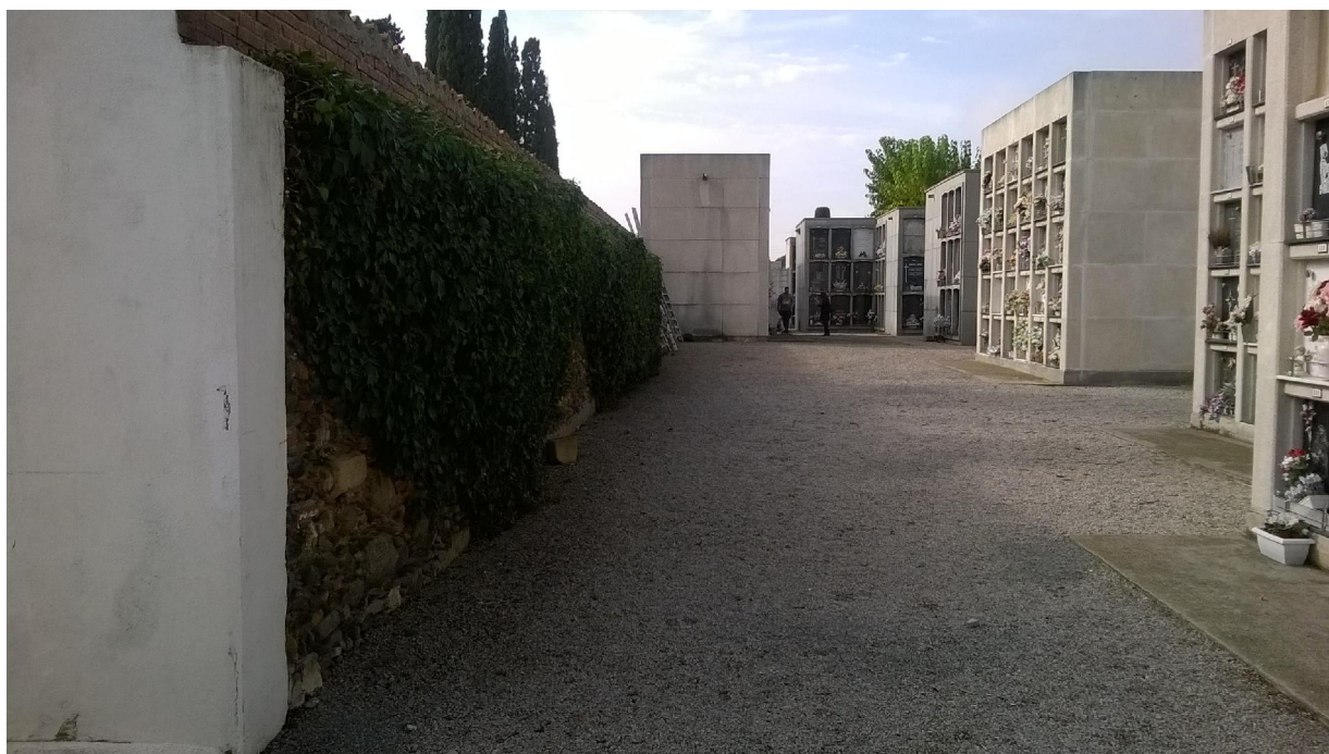
Foto 2. Vista lateral del terreny per a la prolongació del nou edifici de ninxols.
