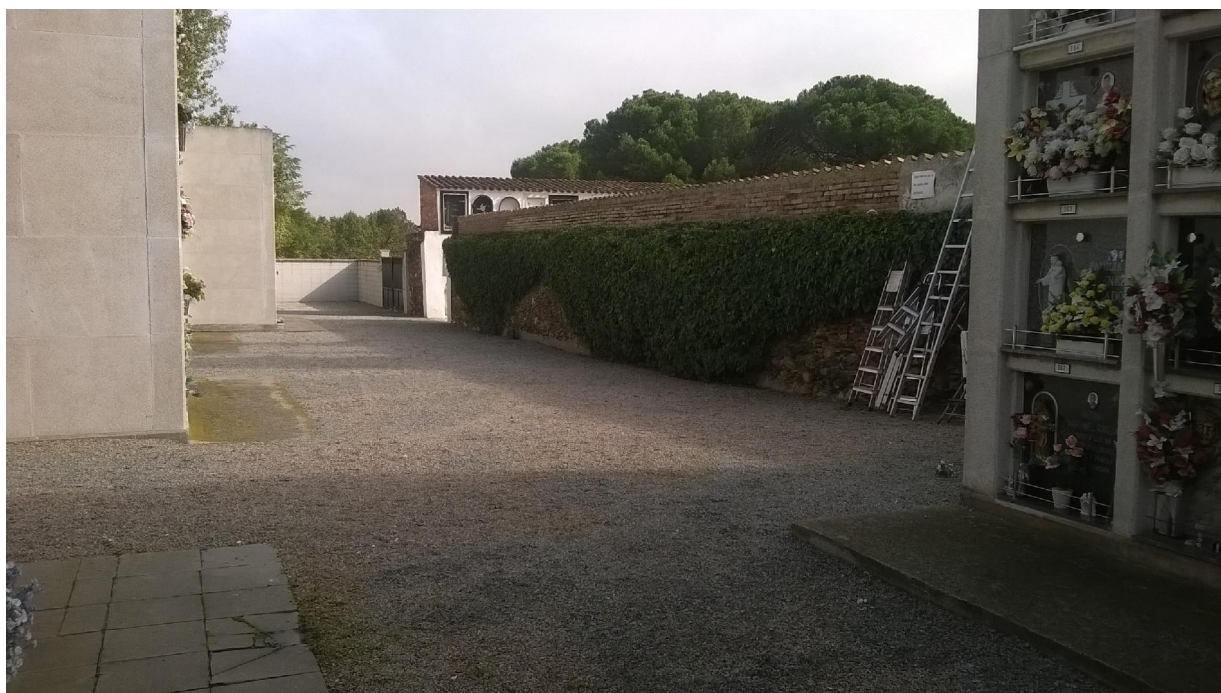
Foto 4. Vista panoràmica de la paret on s'ubicarà el nou edifici de ninxols.
