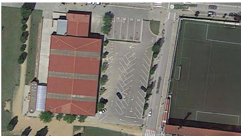
Foto 1: Estat actual del pàrquing
