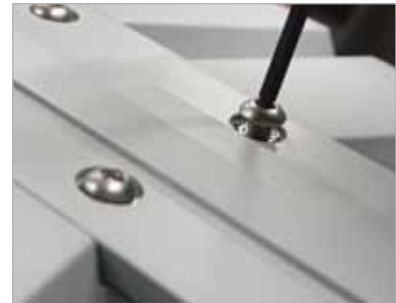
Paso 6 Monte el nuevo chevron LED en el perfil de la luminaria.
