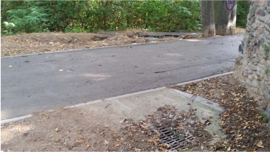
Zona de confluència de l'Av. Catalunya mb el carril bici, on es forma un gual d'escorrentiu d'aigües pluvials. Detall del sorrer/interceptor existent.
