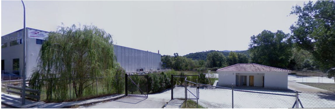
Solar existent d'equipament públic (clau E1), des del vial paral·lel a la C-35, on es pot veure els vestidors i al fons la pista esportiva.
