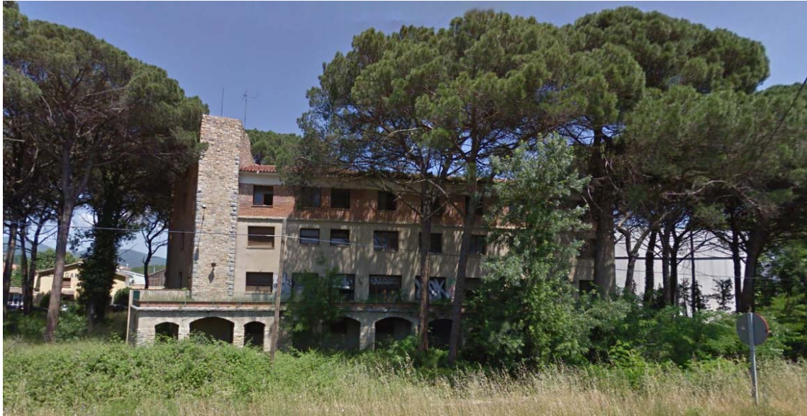
Fig. 2 Edificació en desús existent
