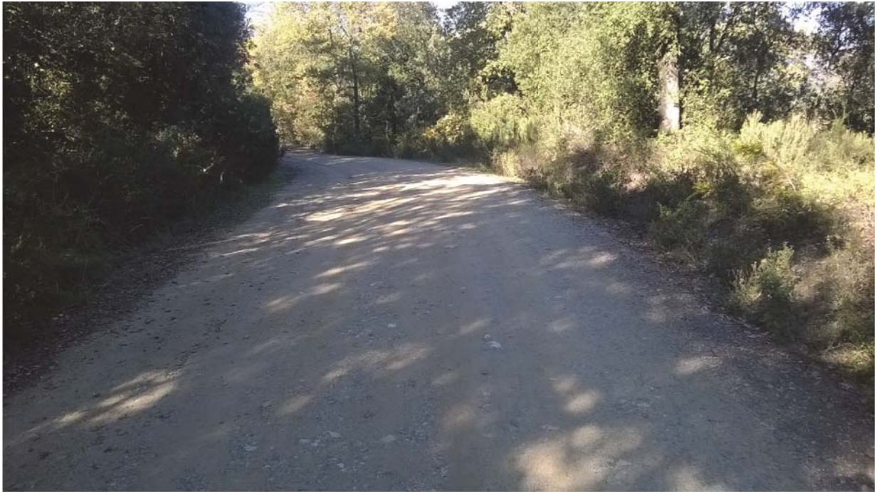
Foto 65. Continuació del camí de Campins. PK 1+540.
