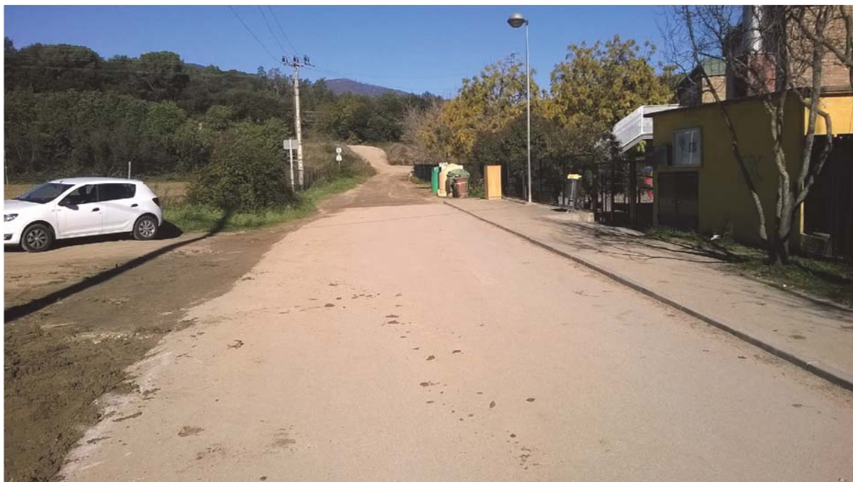
Foto 4. Tram asfaltat al camí de Campins.
