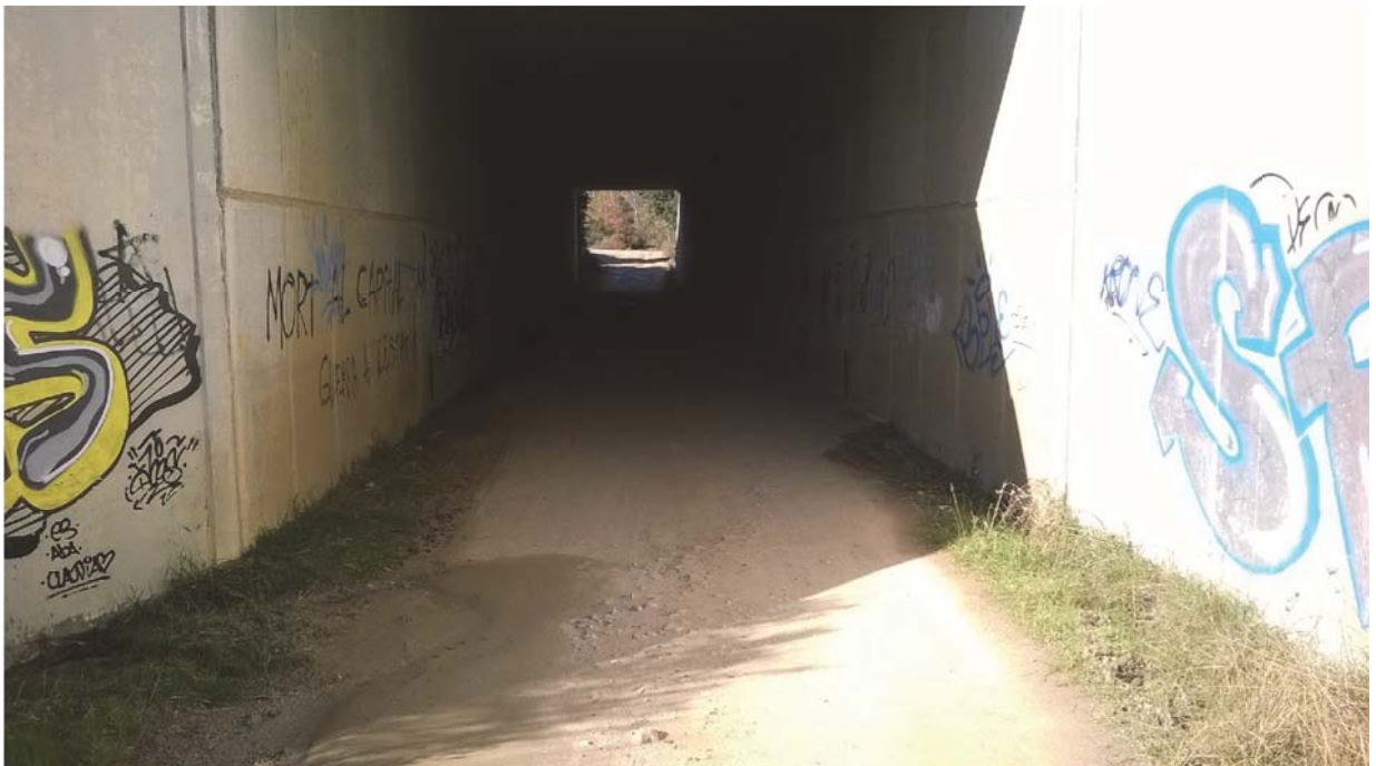
Foto 26. Inici del túnel de l'A.V.E. PK 0+620.
