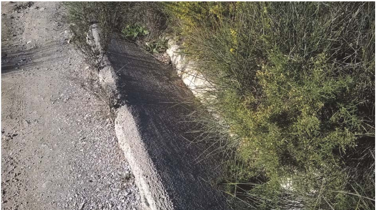
Foto 24. Cuneta de formigó a la baixada cap al túnel de l'A.V.E. Marge dreta.
