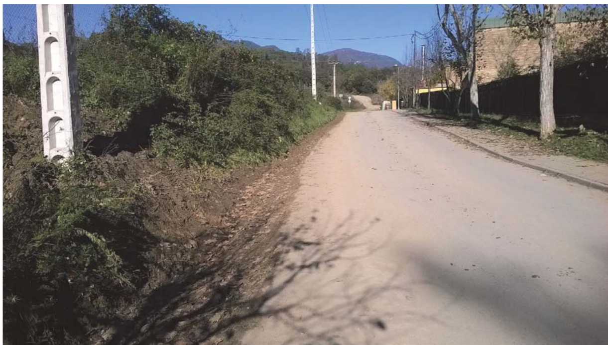
Foto 3. Tram asfaltat al camí de Campins.
