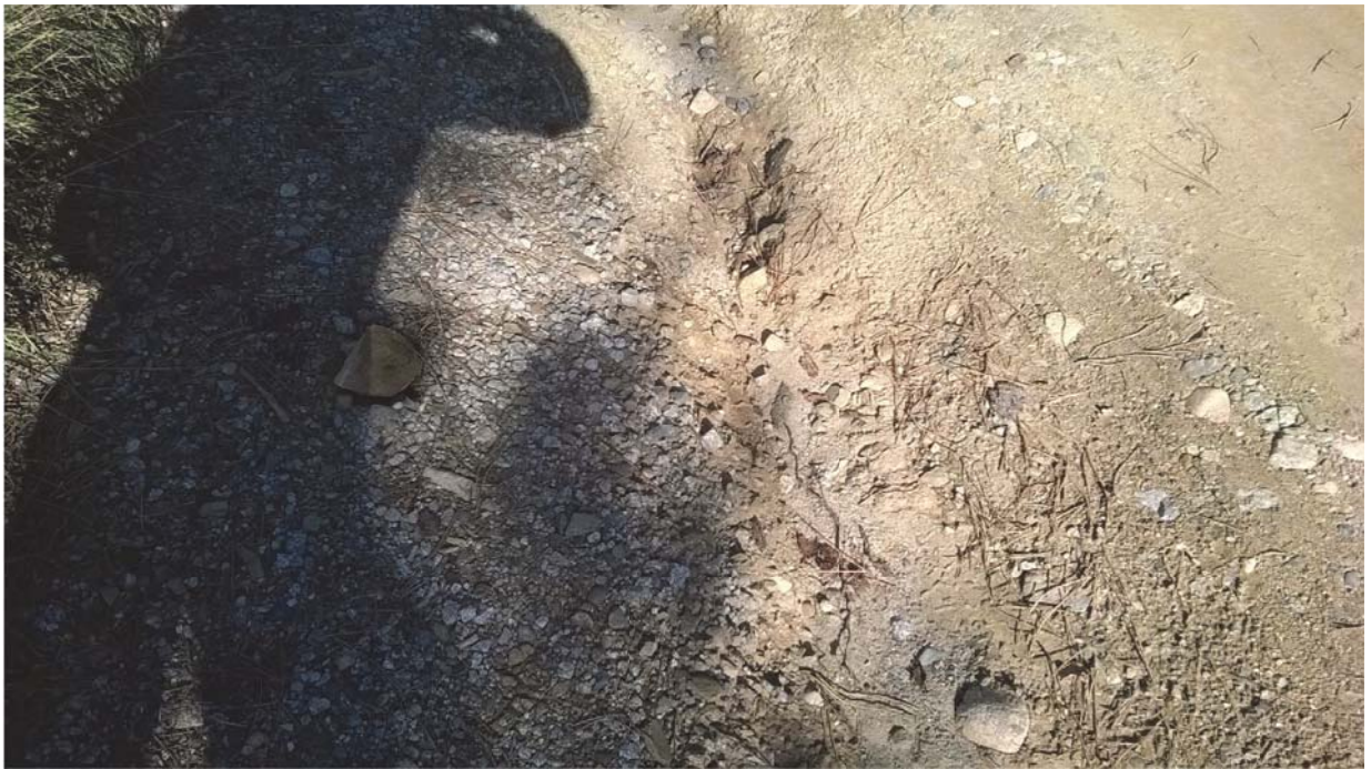
Foto 45. Continuació del camí de Campins. PK 1+120. Tram en mal estat.
