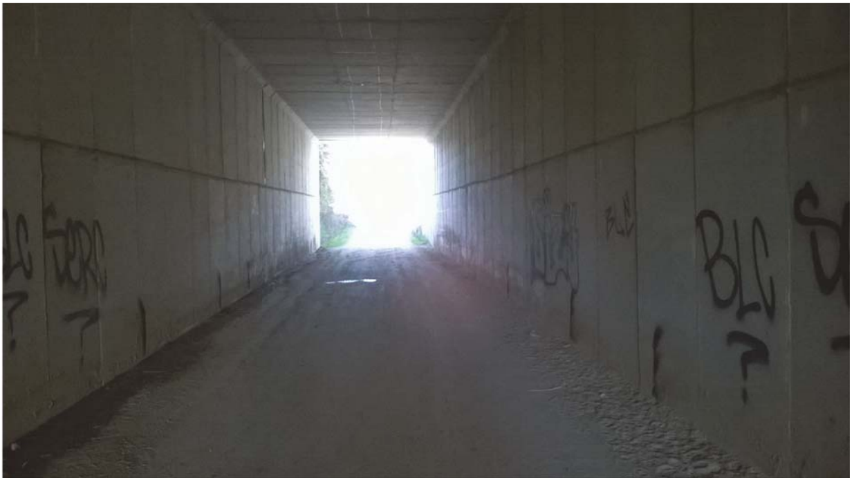
Foto 27. Interior del túnel de l'A.V.E. PK 0+640.
