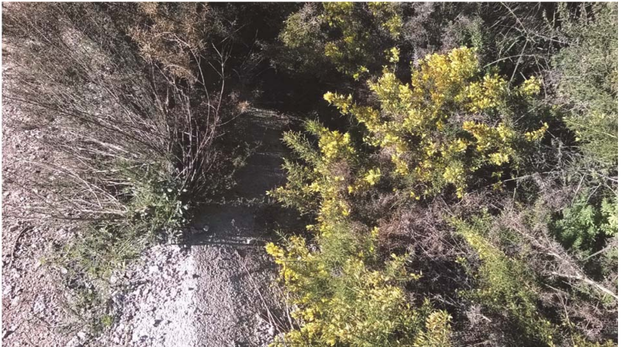
Foto 23. Cuneta de formigó a la baixada cap al túnel de l'A.V.E. Marge dreta.
