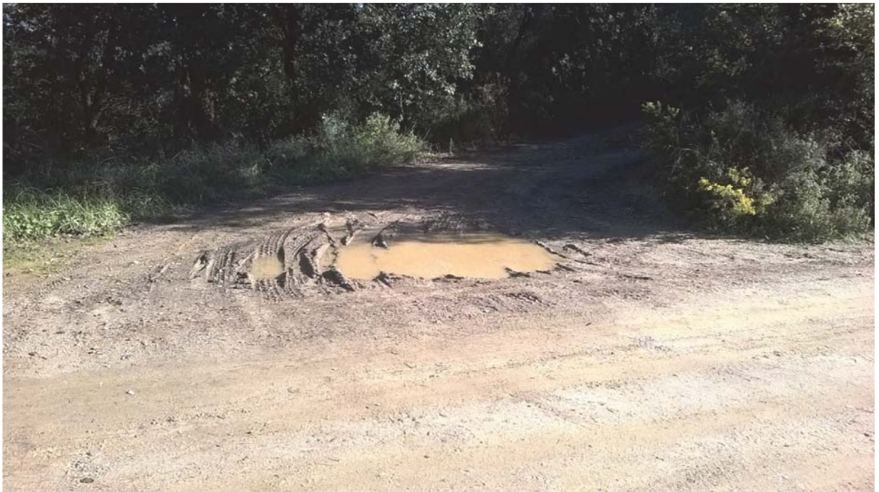
Foto 63. Bassals al camí de Campins. PK 1+480. Connexió amb camí. Marge dret.
