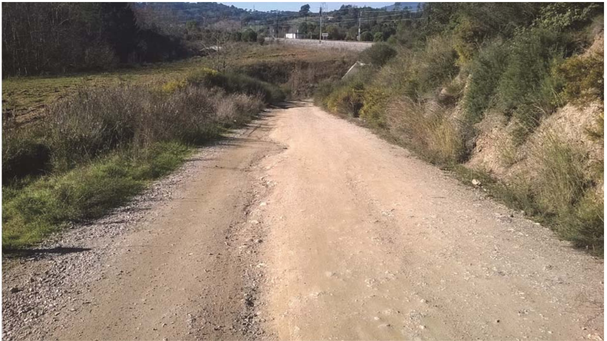
Foto 21. Baixada cal al túnel de l'A.V.E. PK 0+600.
