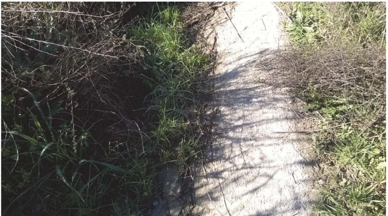
Foto 22. Cuneta de formigó a la baixada cap al túnel de l'A.V.E. Marge esquerre.
