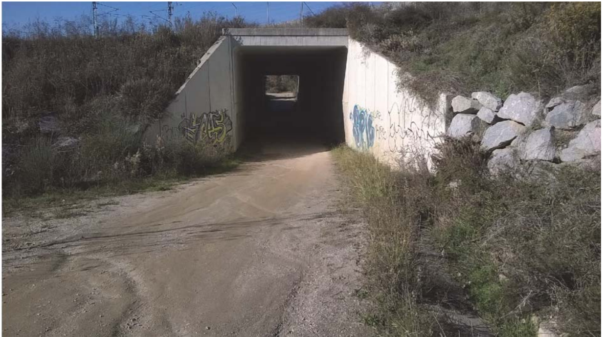
Foto 25. Inici del túnel de l'A.V.E.
