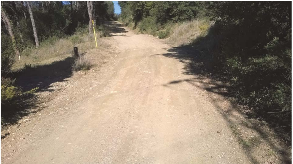
Foto 55. Continuació del camí de Campins. PK 1+330. Canalització de gas que creua el camí.
